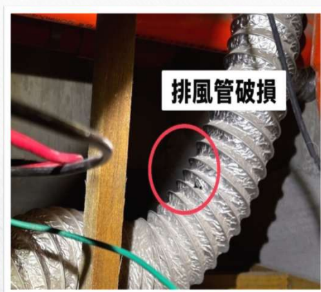
排風管線破損
