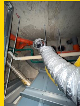
| 排風管破損 |
